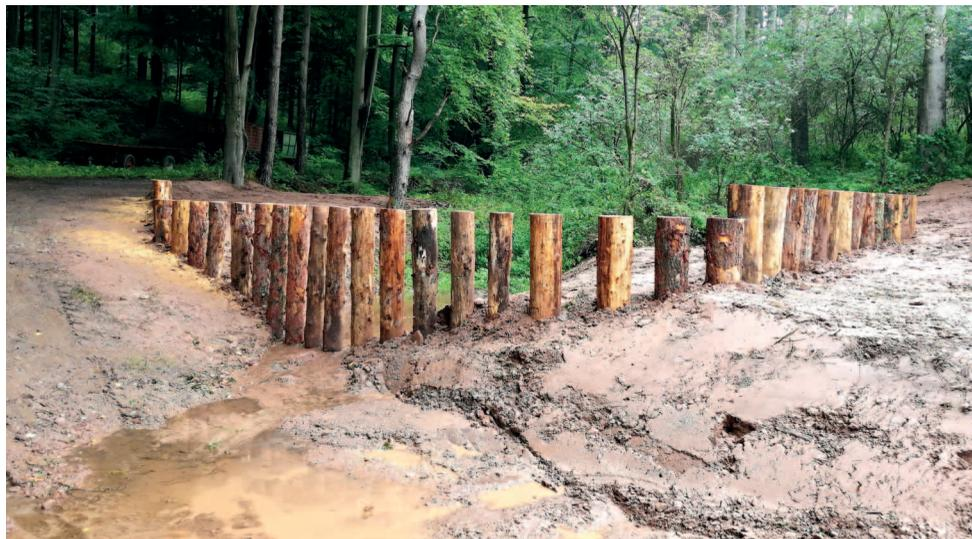
Geschiebeperrren halten Abflussquerschnitte länger frei
