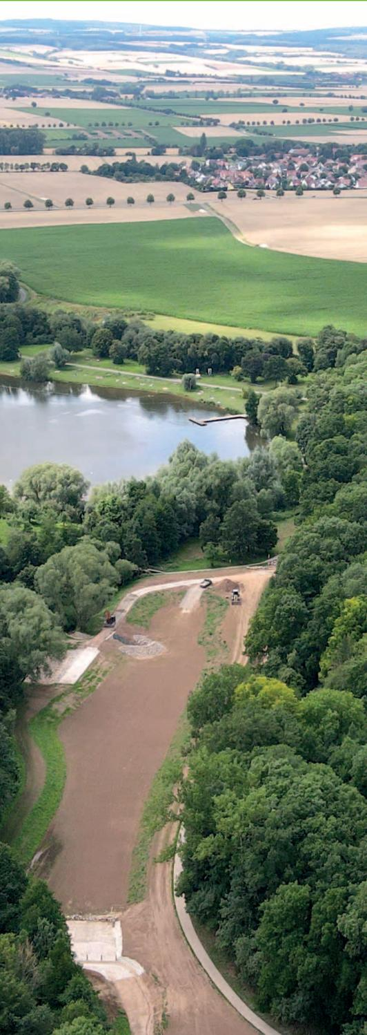
Innerhalb eines Zeitraumes von zehn Jahren wurden ca. 18.000 m<sup>3</sup> Sedimentmaterial (überwiegend Feinsedimente) aus dem Wendebachstausee ausgeräumt und entsorgt.
