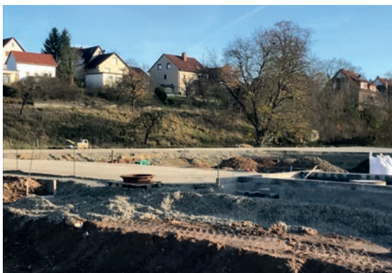
Erschließungsarbeiten im Neubaugebiet „Klothgasse“
