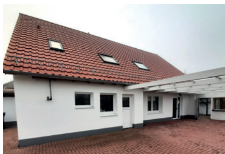
Wände wurden isoliert und neue Fenster eingesetzt.
