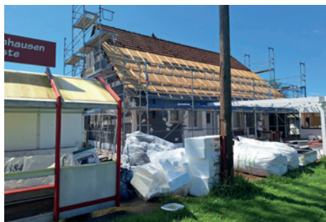
Das Sporthaus Ballenhausen wurde saniert: Dach und
