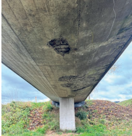
Hier sieht man den Schaden an der Brücke von unten.
