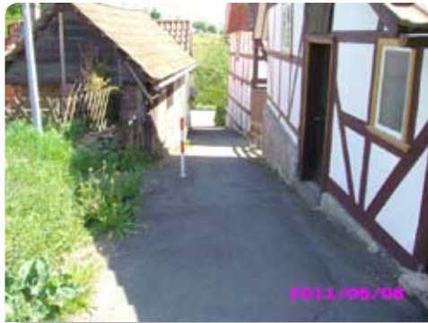
Fußweg vor der Erneuerung
