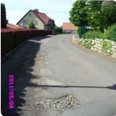
Straße vor dem Ausbau
