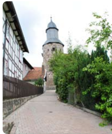
Fußweg nach der Erneuerung
