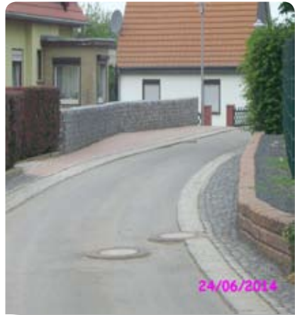
Straße nach dem Ausbau
