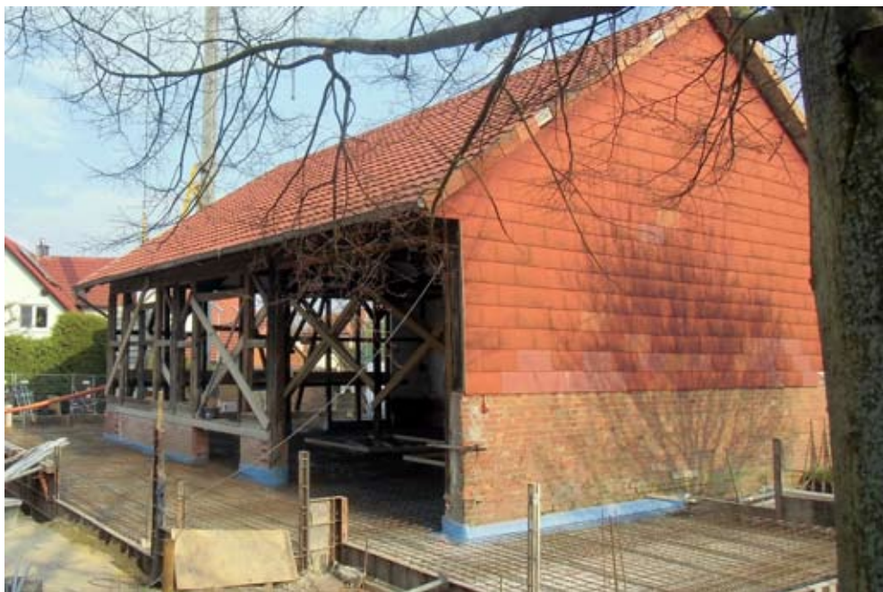
Die Tenne in Elkershausen wird mit EU-Mitteln erneuert.
