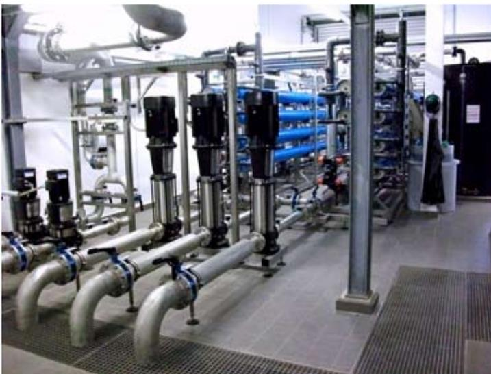
Entkalkungsanlage für weiches Wasser
